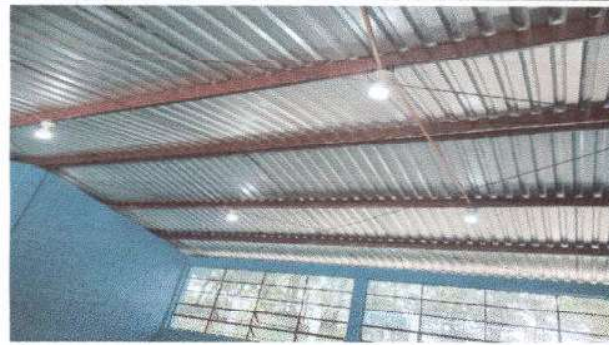
Foto 2: Reparación de Cableado eléctrico modulo de aulas
